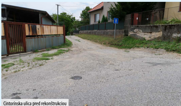
Cintorínska ulica pred rekonštrukciou
