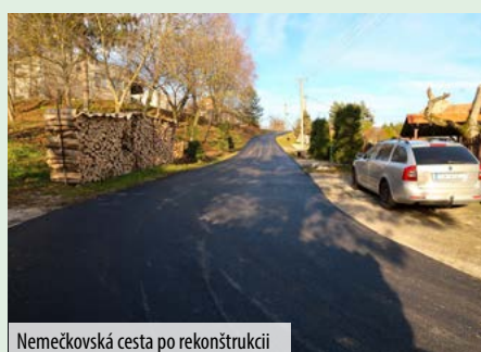
Nemečkovská cesta po rekonštrukcii
