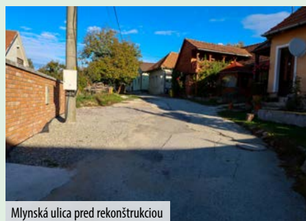
Mlynská ulica pred rekonštrukciou
