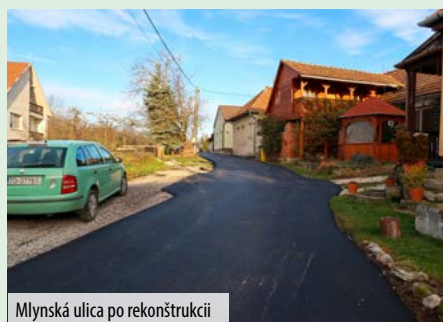
Mlynská ulica po rekonštrukcii
