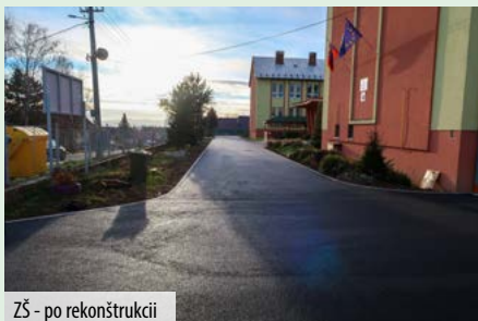
ZŠ - po rekonštrukcii
