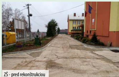
ZŠ - pred rekonštrukciou
