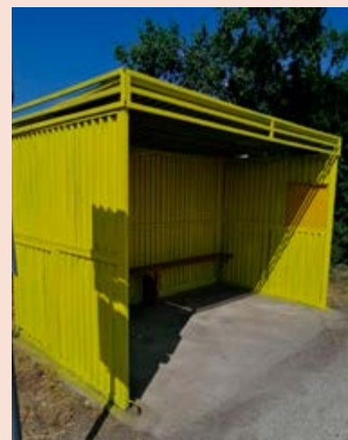
... a po obnove
