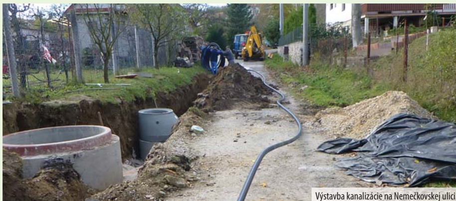
Výstavba kanalizácie na Nemečkovej ulici
