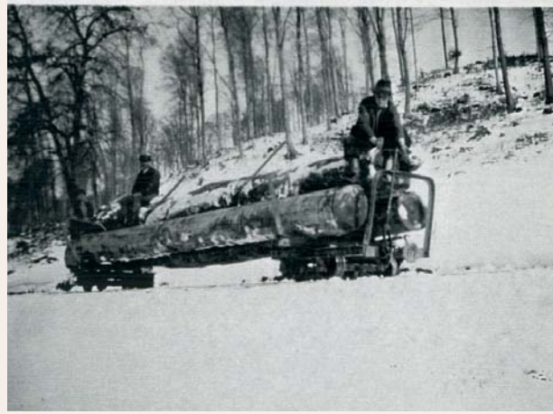
■ Mechanické zvážanie dreva na prispôsobenom podvozku (povagli) vagóna po koľajniciach zo Stokov dolu kopcom do depa na Duchonke. Brzdári regulovali rýchlosť zvážania. Koníky šli s pohoničom pešo za nákladom. Po vyložení dreva v depe ťahali koníky po koľajniciach podvozok naspäť do hory.
